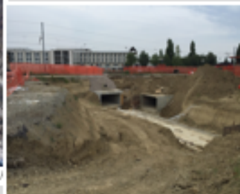
Canale Martiniana completamento dell'attraversamento interrato ferrovia Modena Sassuolo (4 giorni 2014)
