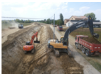
Segno - Pali in cemento armato di sezione circolare Ø 80x2,00m (Giugno 2016) A sinistra - Realizzazione Canale a cielo aperto (Agosto 2017)
