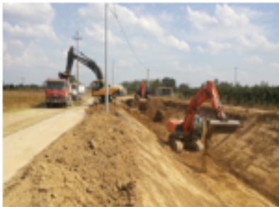
Realizzazione canale a cielo aperto lunghezza di fondo 2,516 con pendenza costante 2/100 pendenza 3,50 % (Agosto 2017)
