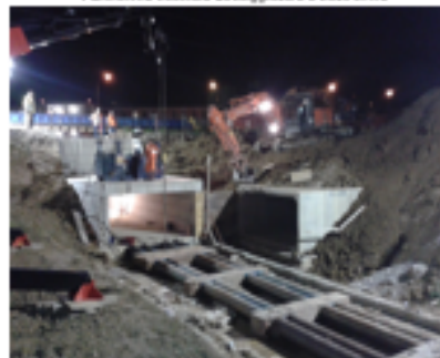
Infissione escavate in c.a. sotto ferrovia Modena - Sassuolo (luglio 2014)
